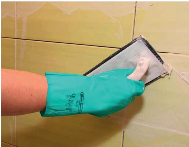
9 Het voegen van hard gebakken tegels met Sopro DF 10®.
