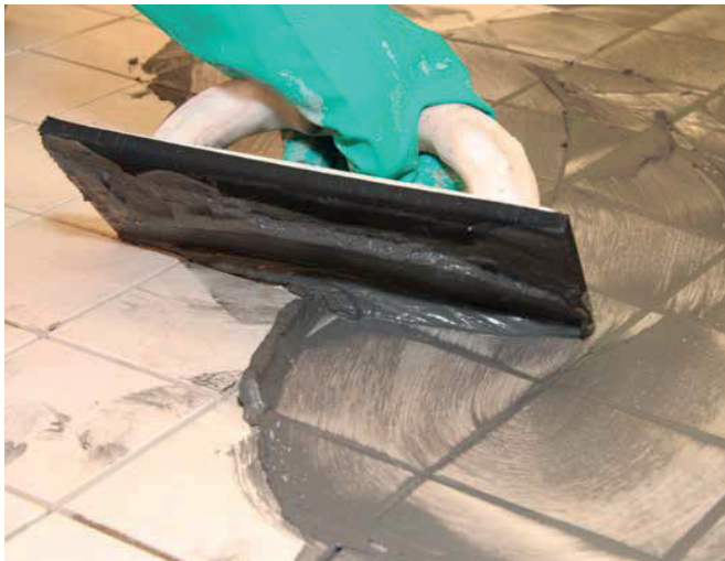
7 Het voegen van tegels met een zeer lage wateropname met Sopro DF 10®.
